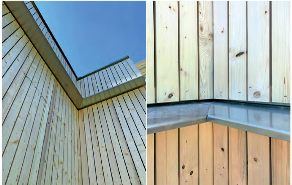
**Abb. 2 :** Brandsperren an einer Holzfassade
